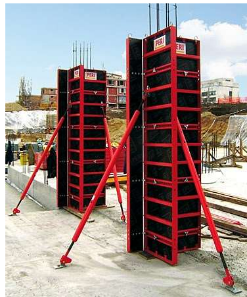
Gambar 3 Bekisting Sistem (PERI) Sumber: www.fjb.kaskus.co.id
